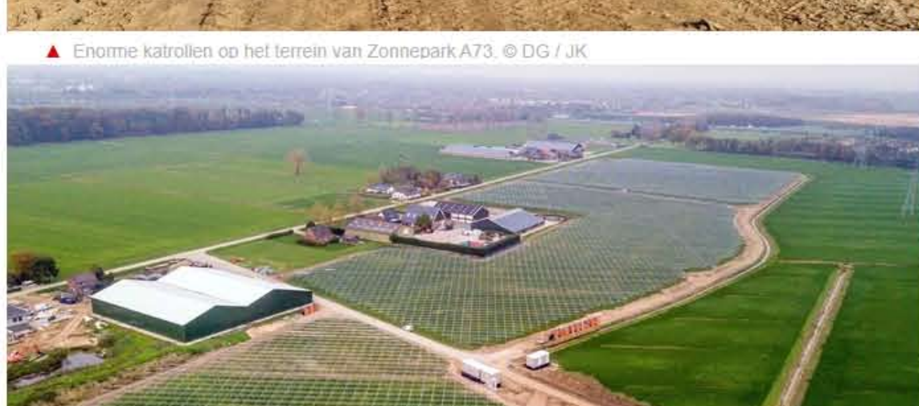
▲ De groene bedrijfshallen dienen tijdens de bouw als opslag voor de aanleg van Zonnepark A73. © Eveline van Elk
